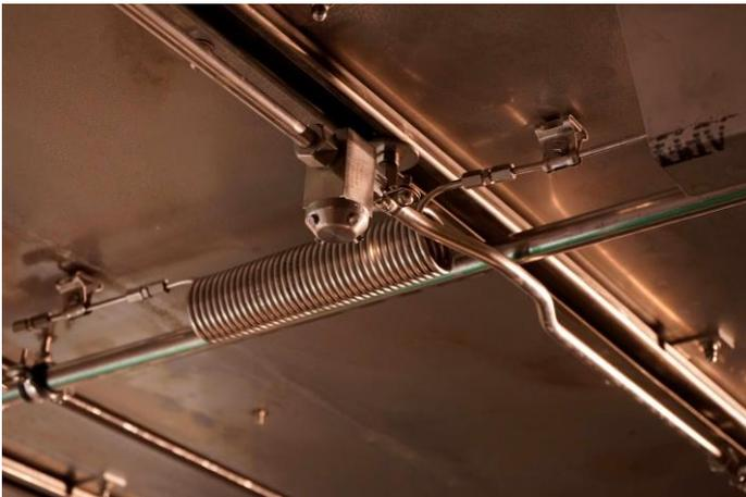
Bildunterschrift: Löschvorrichtung als Teil des Sicherheitskonzeptes für die Erprobung von Battery Packs [Credit: ASAP Gruppe]
